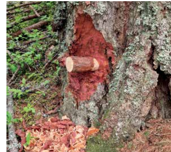
Das Bohrloch muss mit einem Lärchenholz-Stoppel luft- und wasserdicht verschlossen werden.
