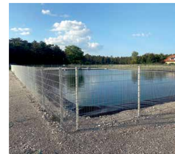
Die Errichtung eines Löschteiches mit einer Teichfolie.
